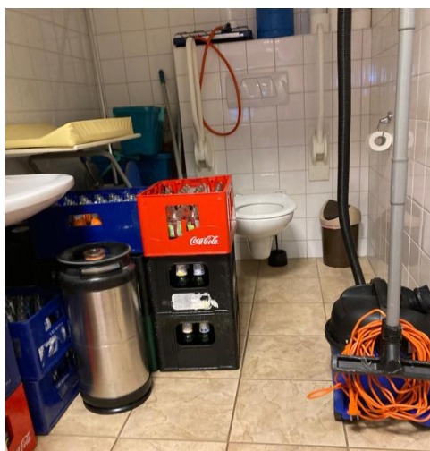
Aangepast toilet in gebruik als opslagruimte.
