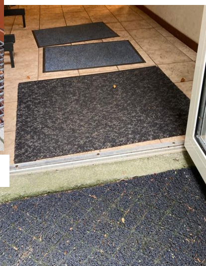
Losliggende matten die niet goed antislip
